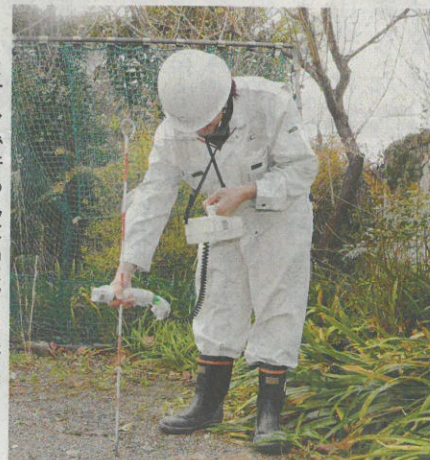
Cエリアで行われた「ホットスポット除染」の現場。敷地内の線量を測定し、高い部分のみを取り除く || 昨年12月、伊達市梁川町
