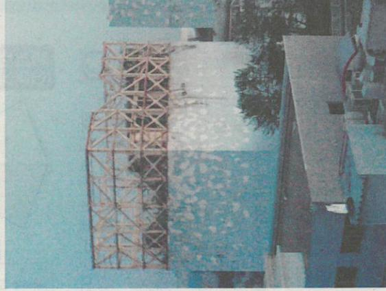
爆発で上部が骨組みだけとなった1号機原子炉建屋=2011年3月12日(東京電力提供)
