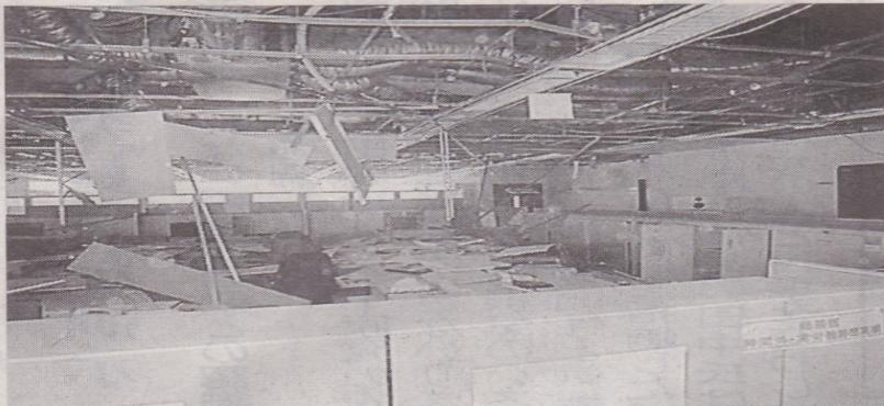
地震で天井パネルが落ちるなどの被害を受けた福島第1原発事務本館=2011年3月11日(東京電力提供)
