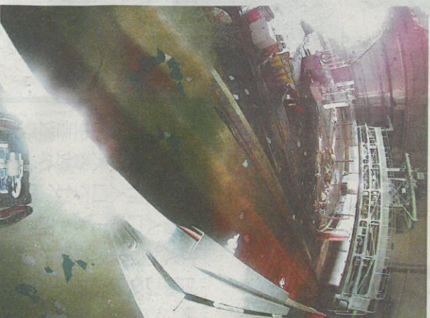
遠隔操作のロボットで撮影した福島第一原発2号機の原子炉建屋と穹。中央部分の下に格納容器がある
